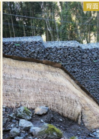
施工事例：鋼製組立網との組み合わせ(正面、側面、背面)
