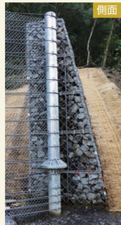
施工事例：鋼製組立網との組み合わせ(正面、側面、背面)
