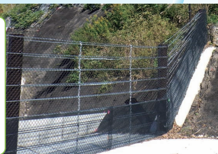
施工事例(勾配付き、端部扇型配置による端部捕捉面)
